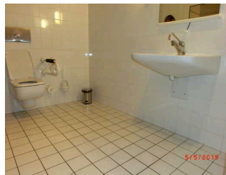
WC mit Haltegriffen in der Lobby
