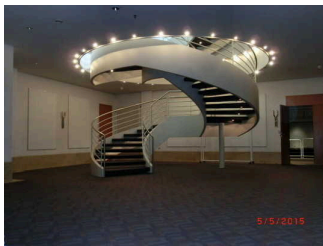
Treppe zur Sauna- und Wellnessbereich
