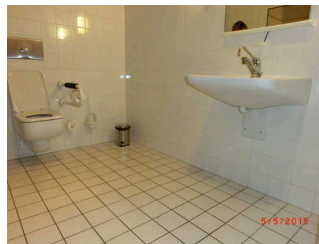
WC mit Haltegriffen in der Lobby
