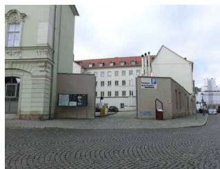
Weg vom Parkplatz zum barrierefreien Nebeneingang mit Treppe und Rampe
