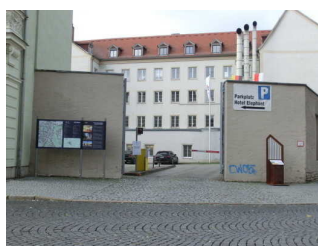
Einfahrt zum Parkplatz mit Schranke
