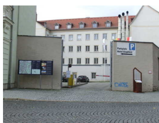
Einfahrt zum Parkplatz mit Schranke
