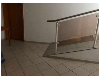
Rampe im UG
