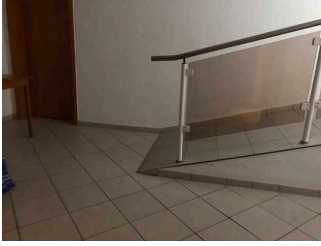
Rampe im UG
