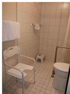
Washbecken im Zimmer nicht im Sanitärraum
