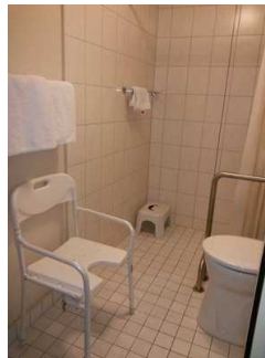
Washbecken im Zimmer nicht im Sanitärraum
