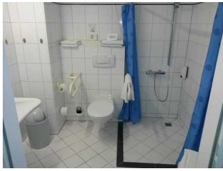
Blick in den Sanitärraum
