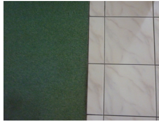
Flure und Wege im Hotel mit Belagwechsel schwellenlos
