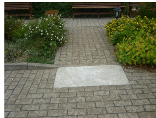
Hoteleingang mit Rampe auf dem Weg 9% Steigung auf 2m Länge
