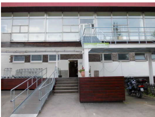
Hotelnebeneingang mit Rampe und Stufen
