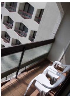
Balkontür 80cm und Stufe mit 19 cm Höhe
