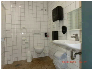
WC mit Haltegriffen in der Lobby
