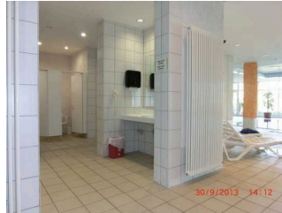
Dusche am Schwimmbad
