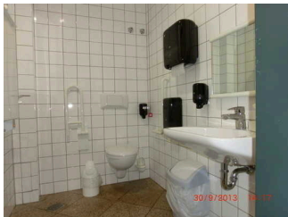
WC mit Haltegriffen in der Lobby
