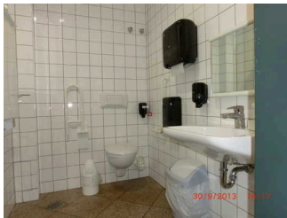
WC mit Haltegriffen in der Lobby
