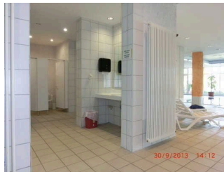
Dusche am Schwimmbad
