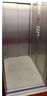
Bedienelemente Im Aufzug
