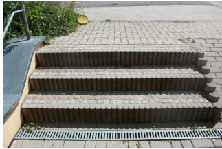
Treppe und Rampe auf dem Weg zum Seitengebäude
