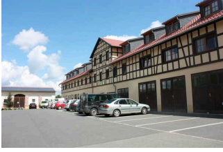
Parkplatz am Gästehaus
