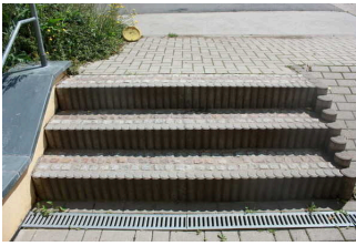
Treppe und Rampe auf dem Weg zum Seitengebäude
