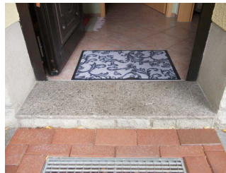
Blick auf Schwelle am Eingang zur Ferienwohnung
