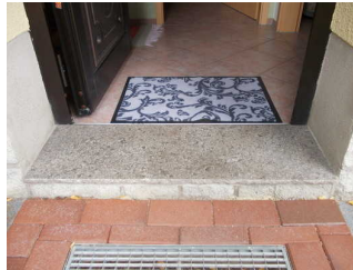
Blick auf Schwelle am Eingang zur Ferienwohnung
