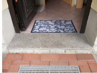
Blick auf Schwelle am Eingang zur Ferienwohnung
