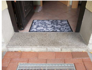
Blick auf Schwelle am Eingang zur Ferienwohnung
