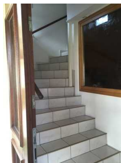
Blick auf die Treppe von oben
