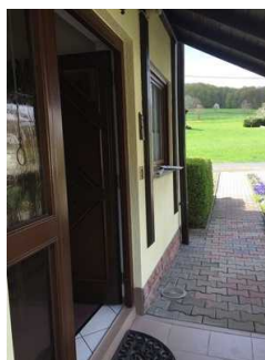
Blick auf die Eingangsschwelle
