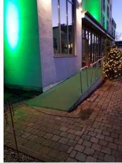
Rampe am Eingang
