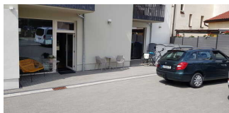
Weg ab Parkplatz bis Seiteneingang
