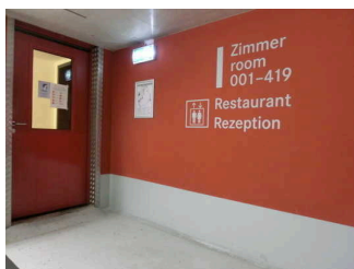
Tür Tiefgarage im 1. UG mit 11 cm Schwelle zum Aufzug
