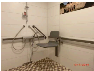
Duschsitz seitlich und in der Höhe verstellbar
