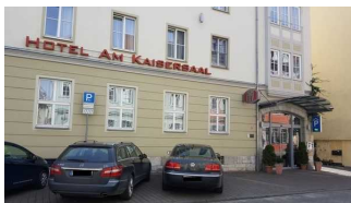
Hotel Am Kaisersaal
