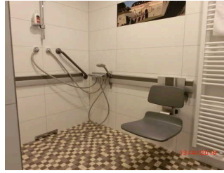
Sanitärraum Zimmer 007 mit seitlich verstellbarem Duschsitz
