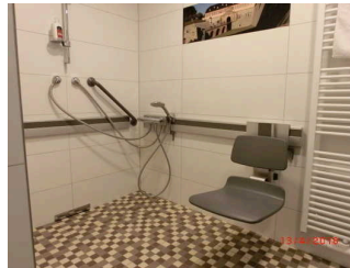
Duscharmatur seitlich und in der Höhe verstellbar
