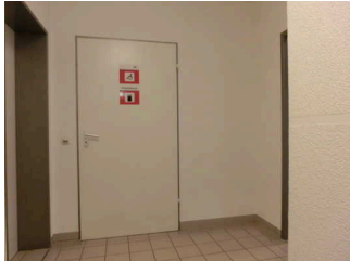
Tür Öffentliches WC Erdgeschoss
