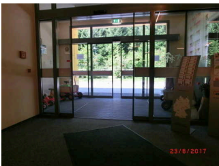
Eingangstür und Windfangtür
