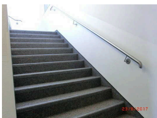
Treppe am Aufzug
