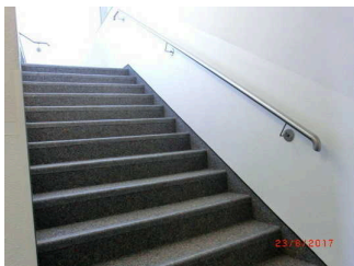
Treppe am Aufzug
