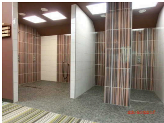
Saunabereich mit bodenebener Dusche
