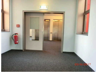
Tür zum Treppenhaus und den Aufzügen
