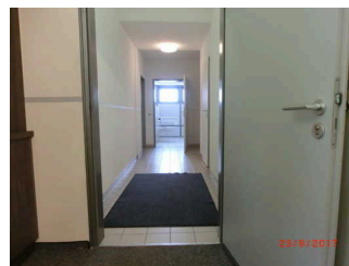
Flur zum WC im Erdgeschoss
